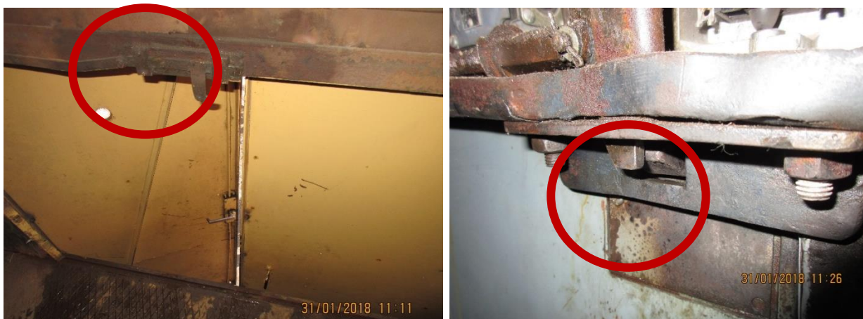
33. att Šahtas durvju slēgmehānismu neatbilstošs stāvoklis (šahtas durvis iespējams atvērt ja pretī neatrodas lifta kabīne)
